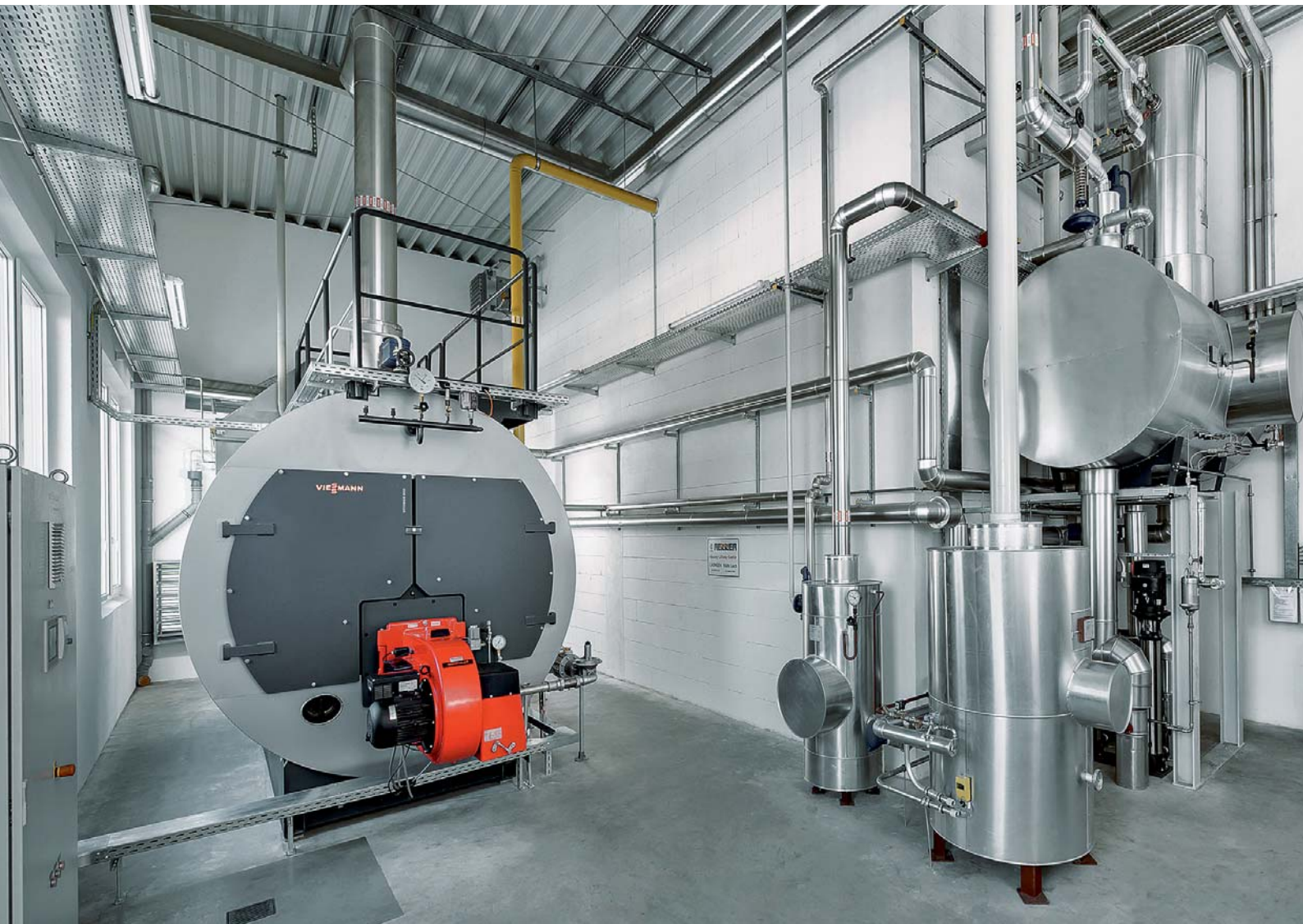
Vitomax 200-HS паровой котел высокого давления 4 т/ч, 16 бар StoVerotec, Германия
