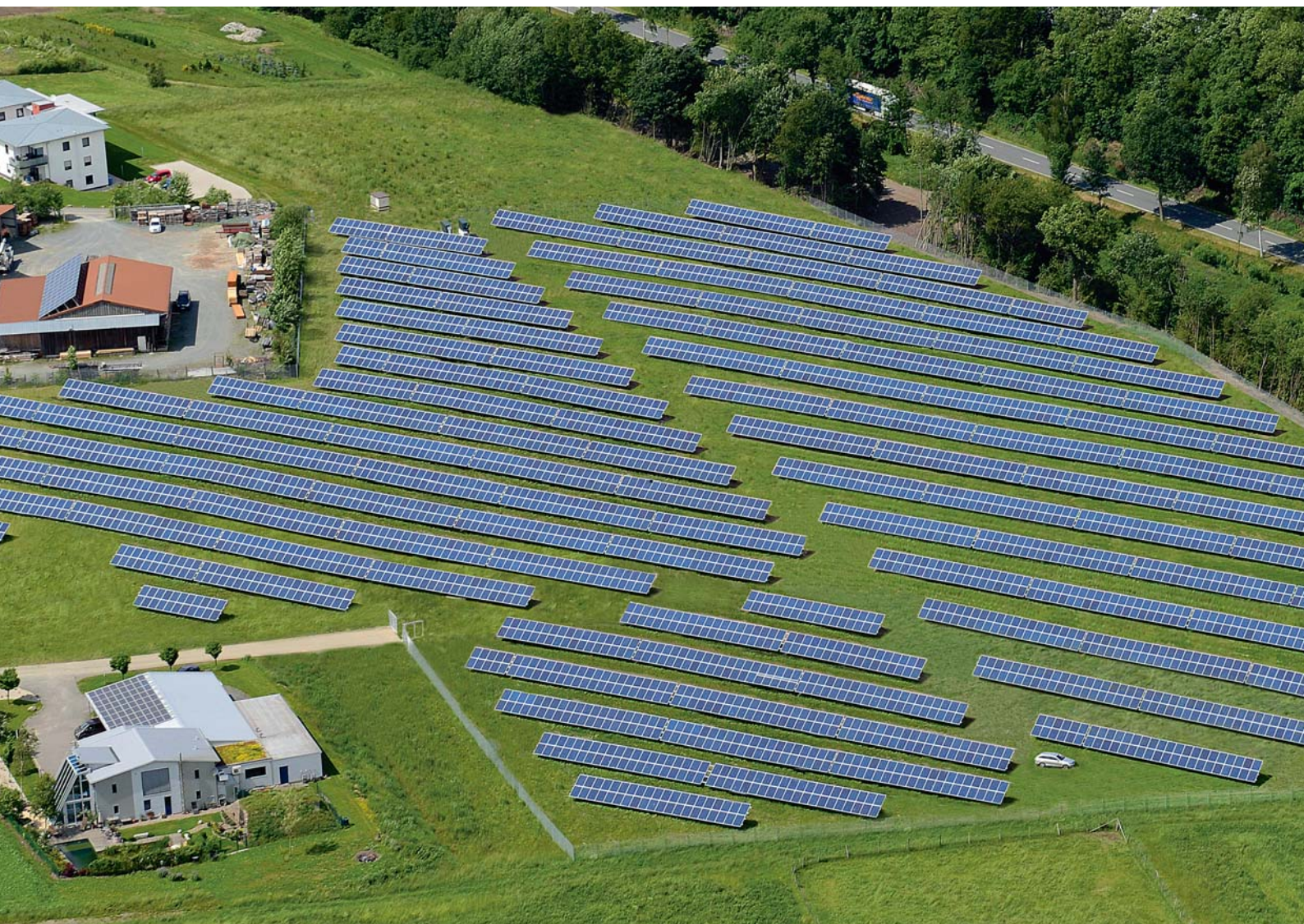
Солнечные батареи для возобновляемой энергии
