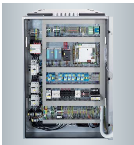
Шкаф управления с интегрированной защитой сети
